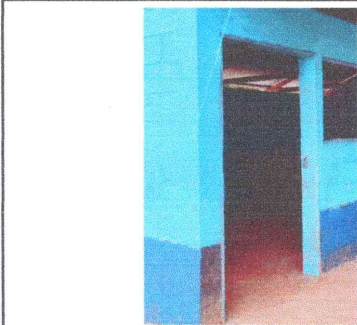
Foto 3: Sustitución de puerta de madera por puerta de metal.
